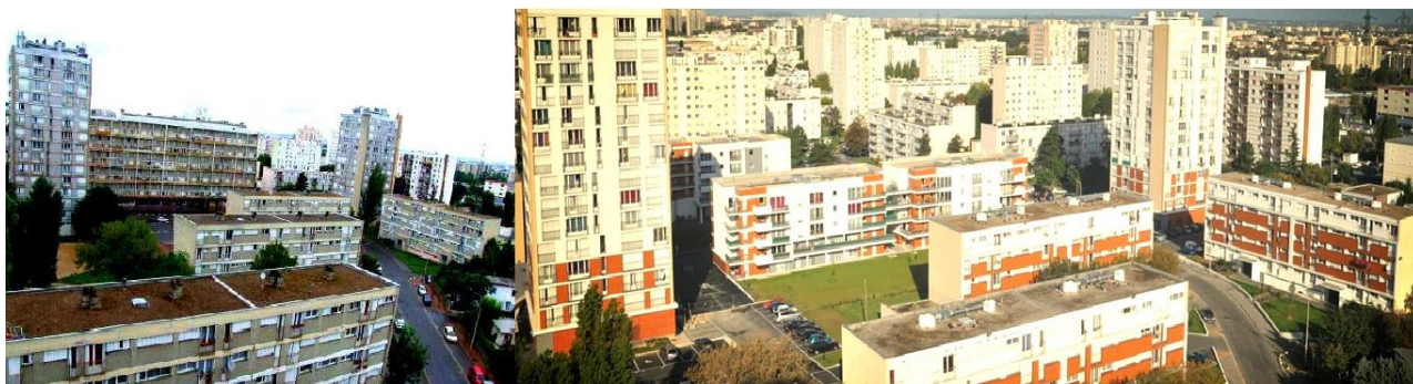
Les Marnaudes avant et après la rénovation urbaine
